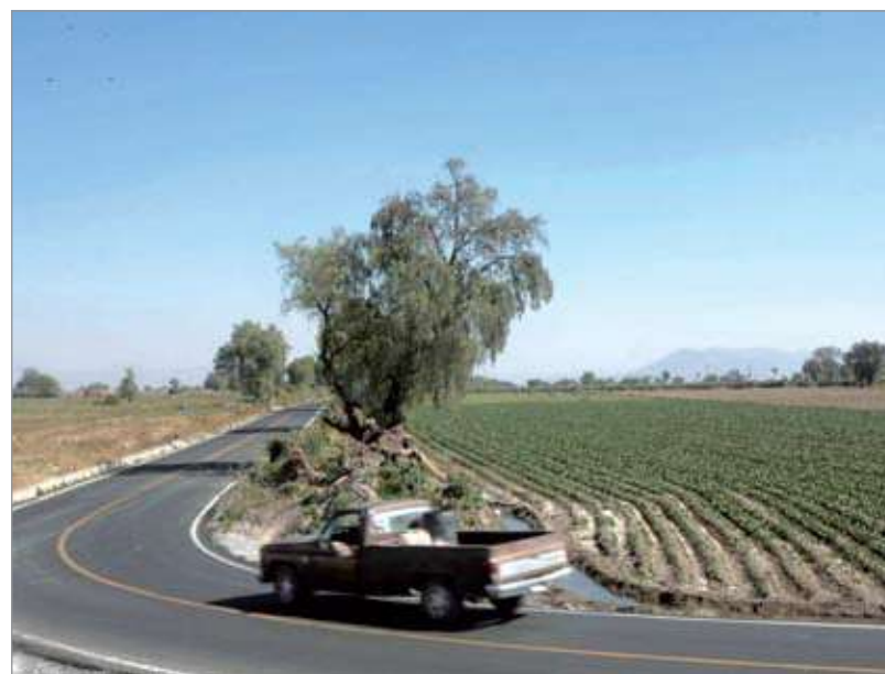
Construcción de la Carretera Los Reyes de Juárez- Guadalupe Calderón
