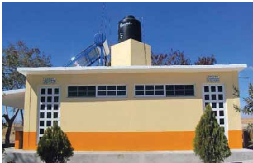
Rehabilitación de albergue escolar
