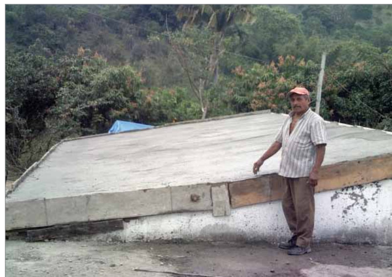
Mejoramiento de vivienda.
