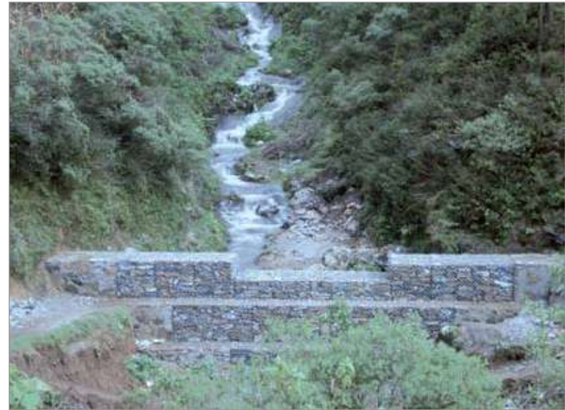
Presa de gavión
