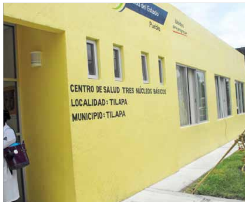
Centro de Salud en mantenimiento preventivo.
