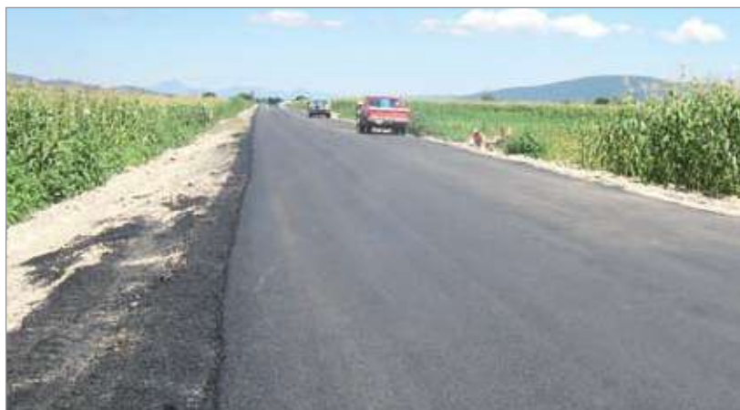
Construcción del Libramiento Tepexi
