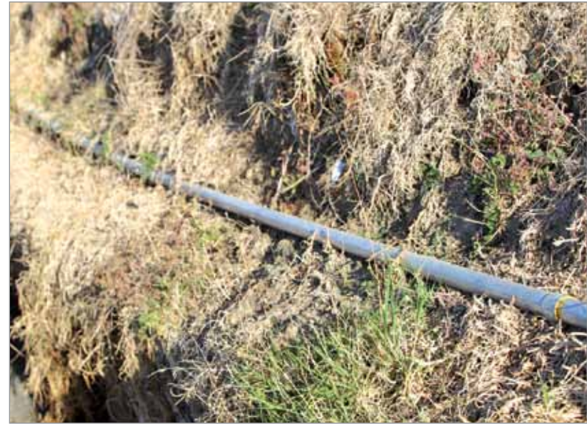
Línea de Conducción de Agua Potable
