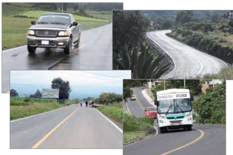
Reconstrucción de Carreteras
