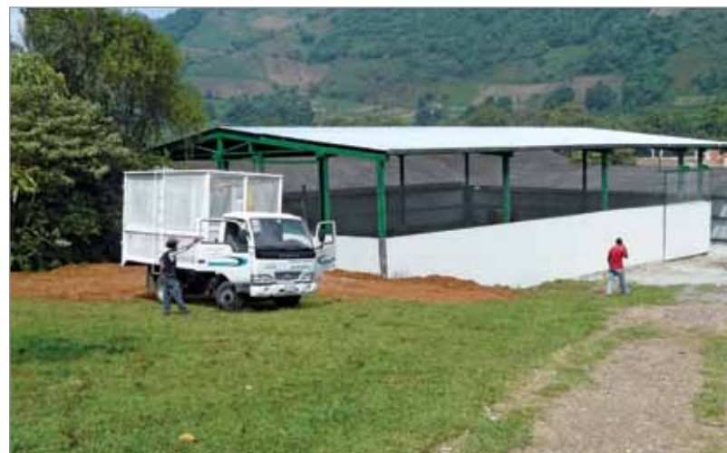
Centro de acopio para residuos sólidos
