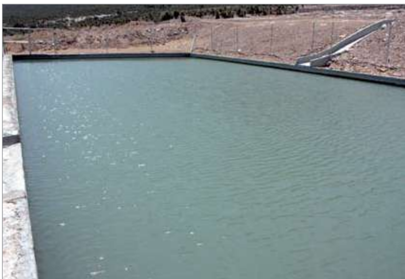
Obras de captación de agua
