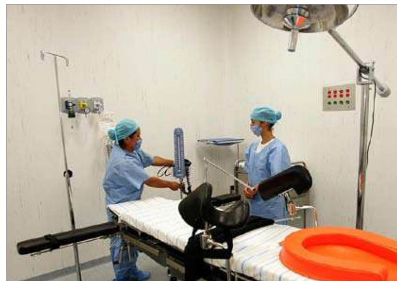
Infraestructura médica de 1 er nivel para los municipios
