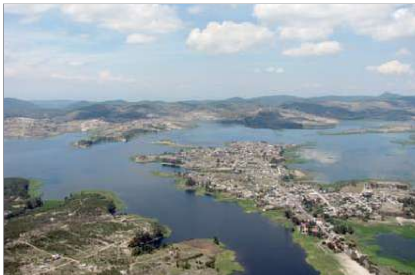
Rescate a la Presa de Valsequillo
