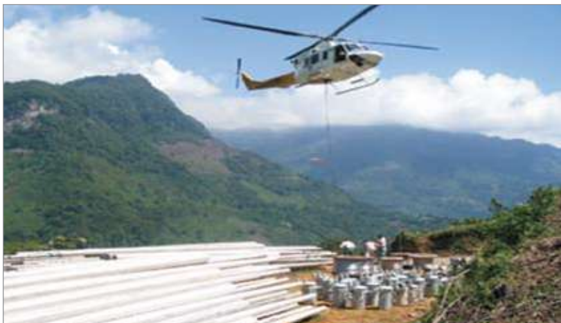
Obras de electrificación
