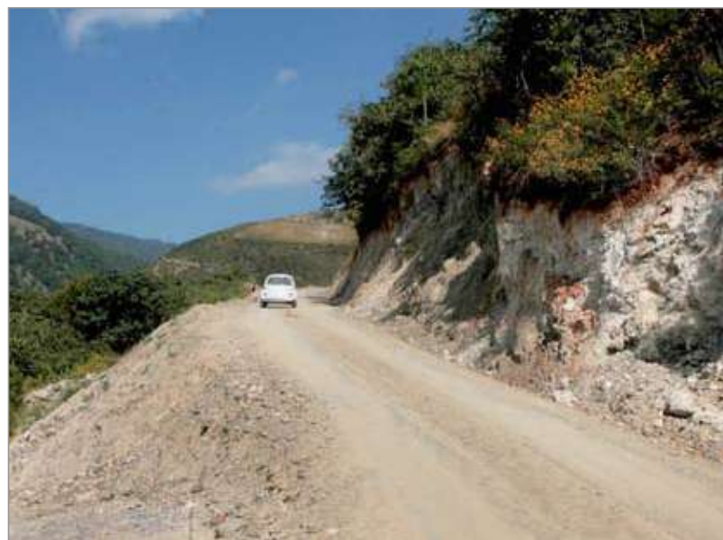
Construcción de caminos
