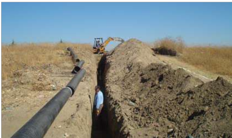
Más obras de drenaje
