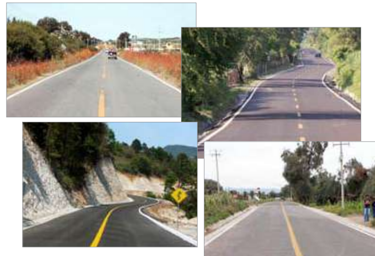
Reconstrucción de Carreteras
