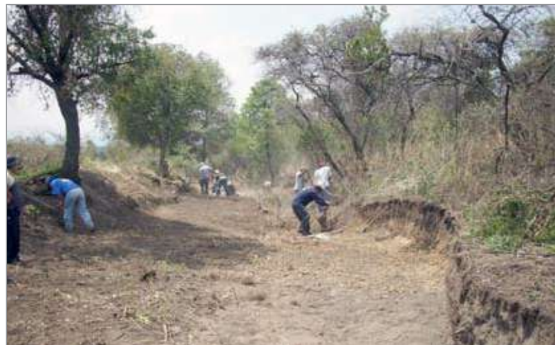
Rehabilitación de caminos
