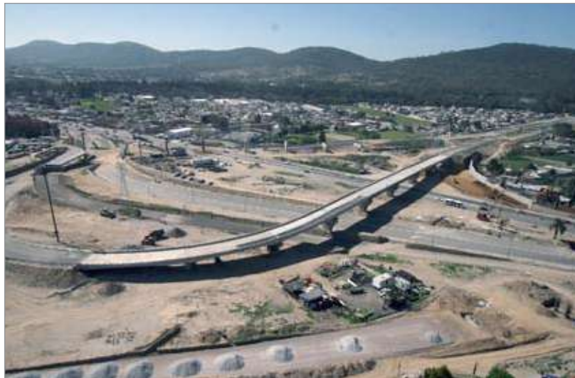
Construcción de carreteras
