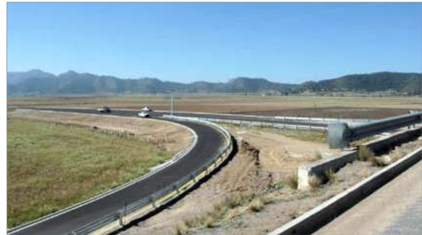
Construcción de Entronque Carretero
