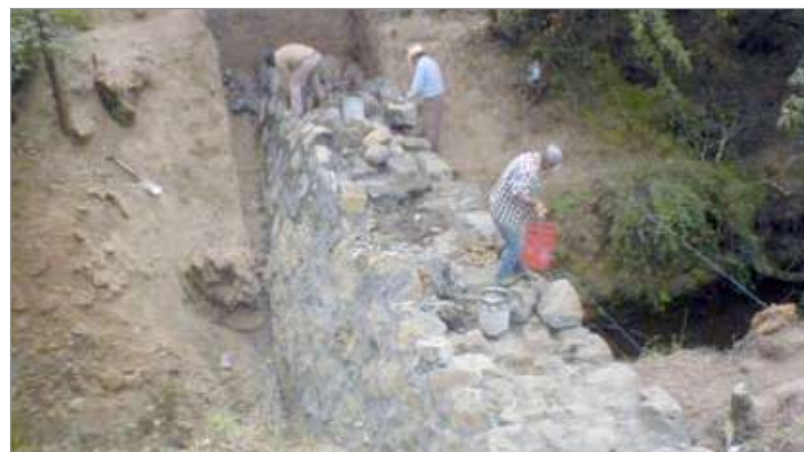
Construcción de presa de mampostería
