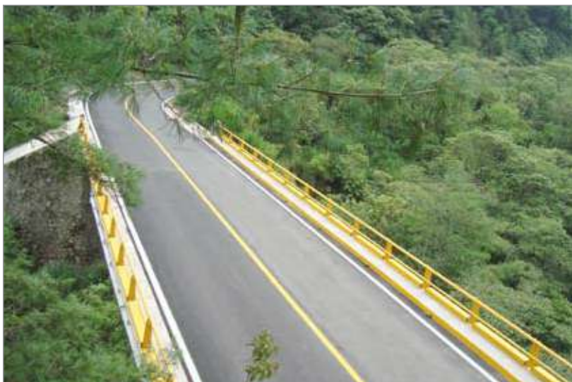
Reconstrucción de puentes
