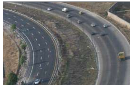
Construcción de vías de comunicación
