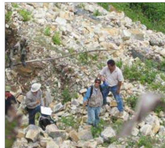
Deslizamiento de rocas
