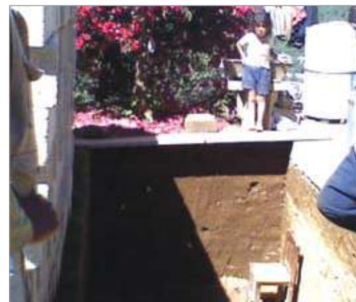
Construcción de fosas sépticas
