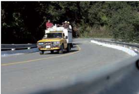
Reconstrucción de carreteras
