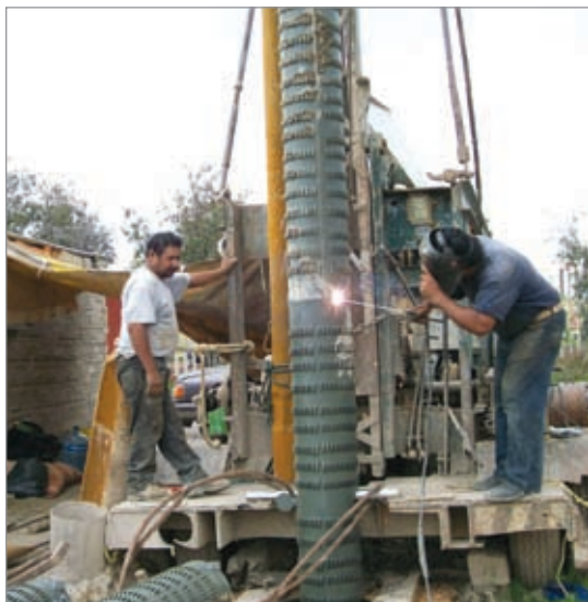
Perforación de un pozo de agua potable. Juan C. Bonilla.
