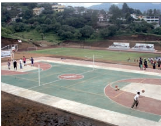
Construcción Unidad Deportiva. Huauchinango.
