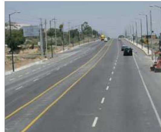
Carretera Puebla-Veracruz. Tramo Chachapa-Amozoc-Tepeaca.
