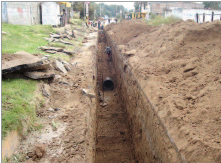
Instalación de tubería PAD de colector marginal, municipio de Cuautlancingo.
