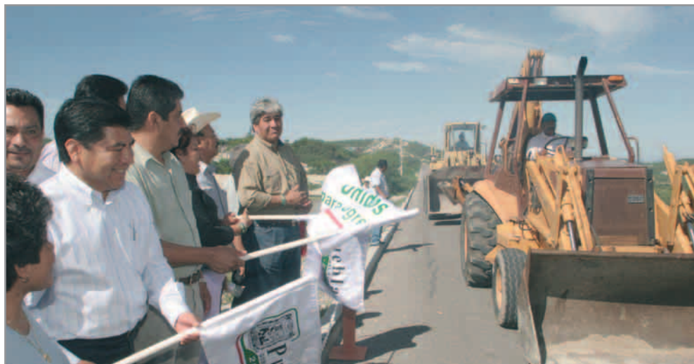
Inicio de la modernización de la carretera Intermixteca, en los municipios de Molcaxac y Zacapala.
