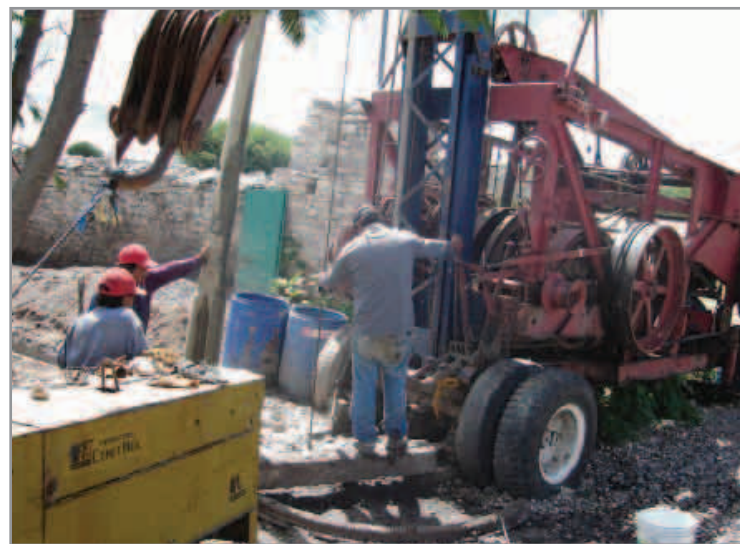
Perforación de pozo profundo para agua potable. Municipio de San Vicente Coyotepec.
