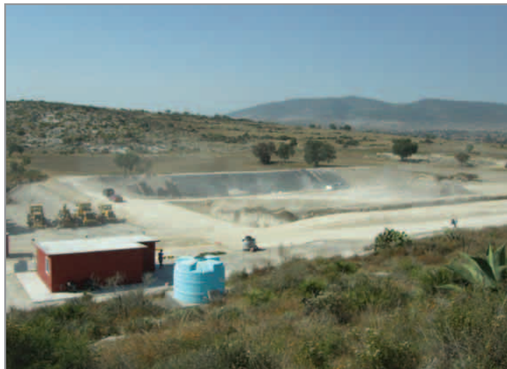
Relleno sanitario intermunicipal de Tepeaca.
