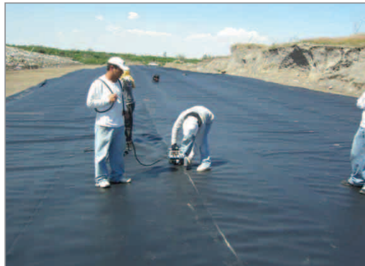
Construcción de nueva celda en el relleno sanitario intermunicipal de Atlixco.
