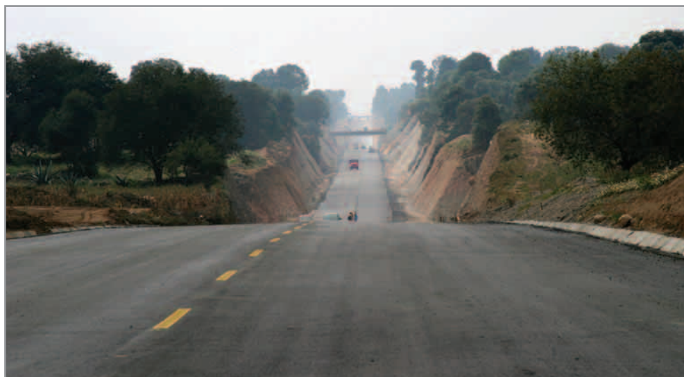
Construcción de la Autopista Amozoc - Perote.
