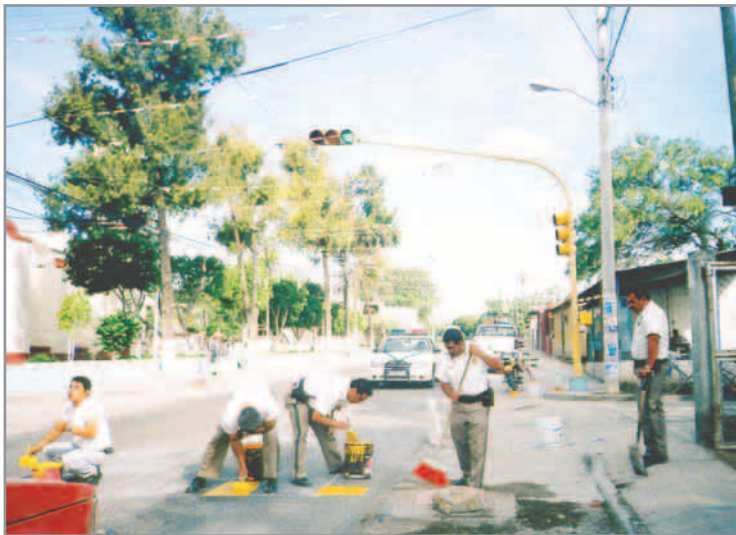
Aplicación de metros lineales de pintura para señalamientos. Municipio de Tehuacán.
